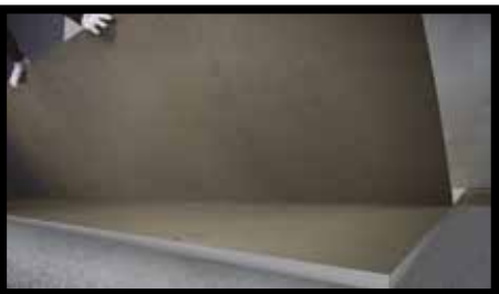
Abb.32 - Beim Verlegen eine der langen Seiten ansetzen und dann zur Tragschicht hin absenken.
