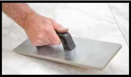
Abb.30 - Nach dem Verlegen der Platte darauf achten, dass der Kleber an allen Stellen gut haftet und keine Leerstellen und Luftblasen entstehen. Zu diesem Zweck müssen gummierte Putzbrettchen verwendet werden (zum Beispiel Raimondi “142G”).
