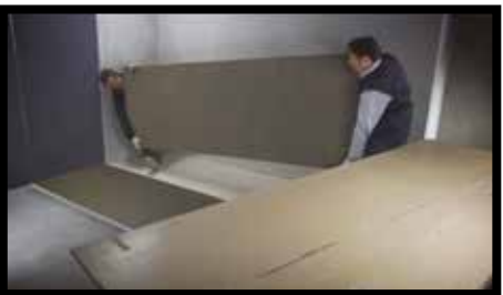
Abb.31 - Beim Tragen der Platten, die Platten zuerst senkrecht stellen und sie dabei am oberen Rand halten; dann die Platte beim Gehen immer mit Hilfe einer Zweitperson gerade haltend befördern.
