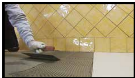
Fig.28 - Cette technique n'est indiquée que pour les mortiers-adhésifs dont la fiche spécifie qu'elles sont adaptées à la pose par "simple encollage". Étendre le mortier-adhésif sur toute la surface du support. Suivre les indications du producteur en ce qui concerne le choix de la spatule et le mode d'étalement.
